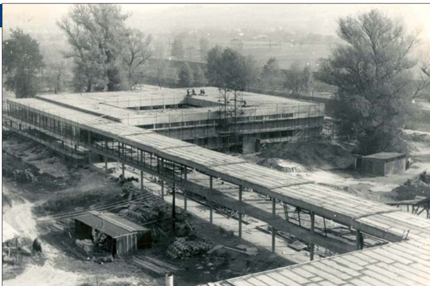
▲ Vystavba Balnea komplexu - začiatok 70. rokov. The Balnea complex under construction at the beginning of the '70s. Der Bau des Balnea-Komplexes - Anfang der 70er Jahre
