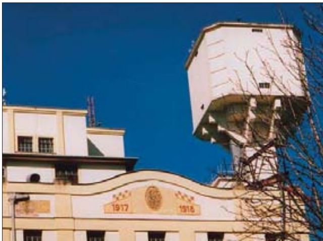
▲ Detail priečelia budovy mlyna. Detail of the flourmill facade. Detailaufnahme der Mühlenfront.
