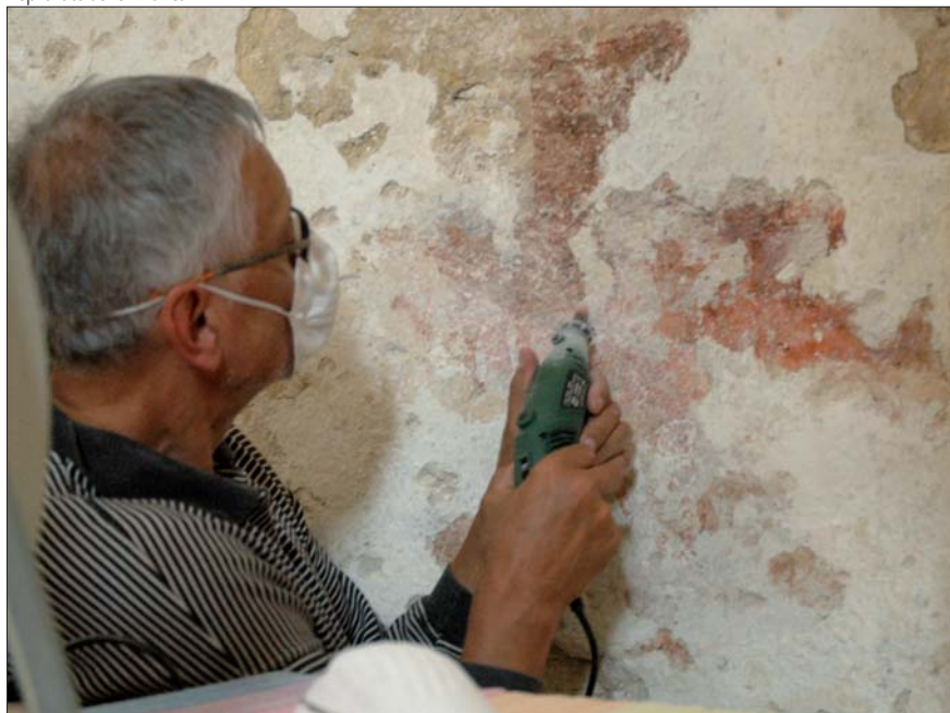
▲ Odkryvanie objaveného konsekráčného kríža zbrusovaním vápenných náterov. Uncovering a consecration cross by stripping the lime paint Die Freilegung eines entdeckten Konsekrationskreuzes durch das Abschleifen der Kalkanstriche
