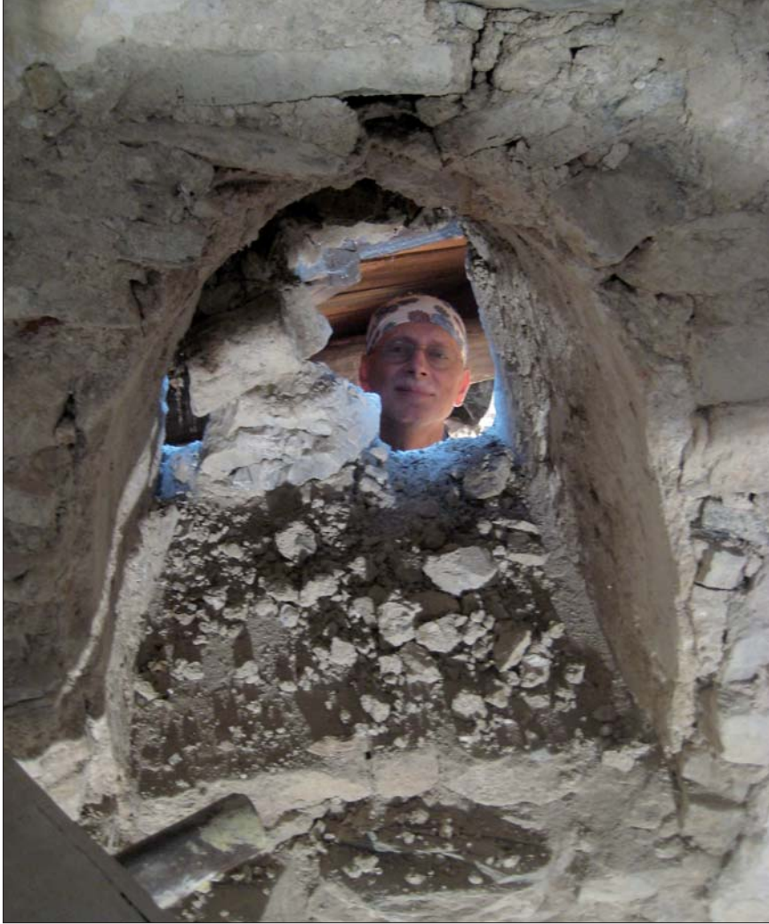
◀ Odkryvanie objaveného najstaršieho predrománskeho okna. Uncovering the oldest pre-Romanesque windows Die Freilegung des entdeckten ältesten vorromanischen Fensters
