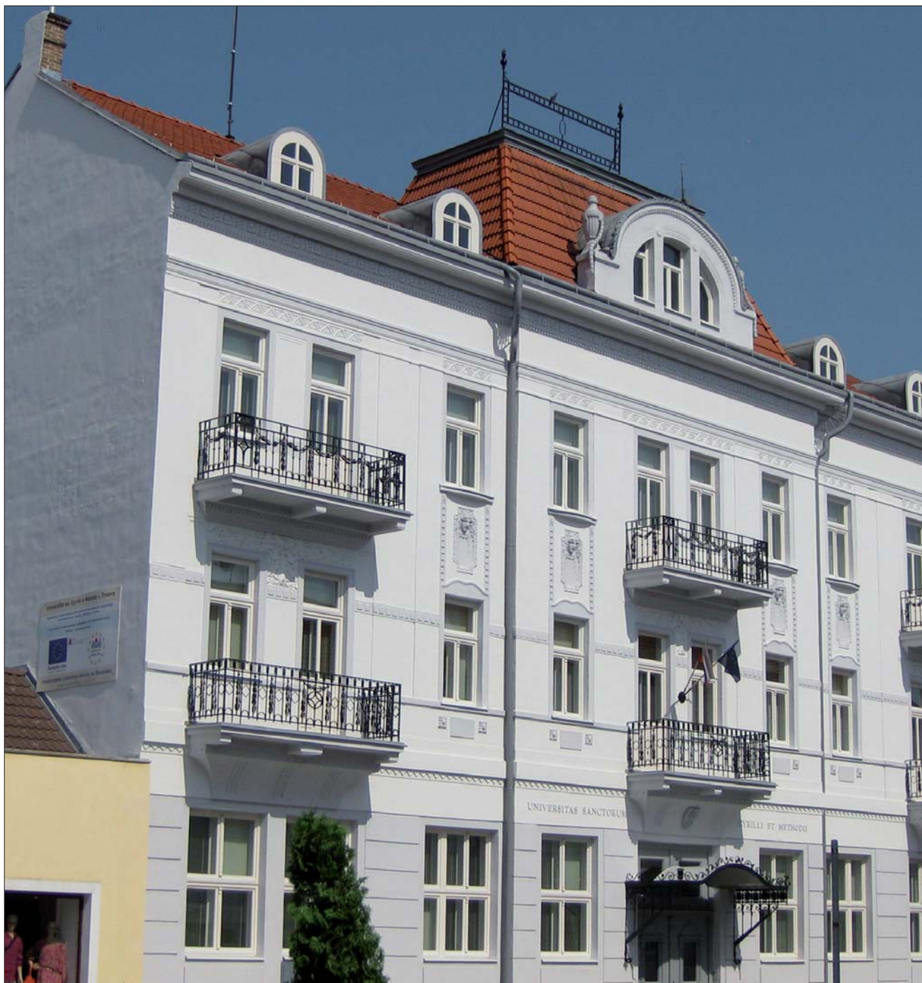
▲ Rekonštruovaný objekt bývalého hotela dnes využíva Inštitút fyzioterapie, balneológie a liečebnej rehabilitácie Univerzity sv. Cyrila a Metoda v Piešťanoch.
