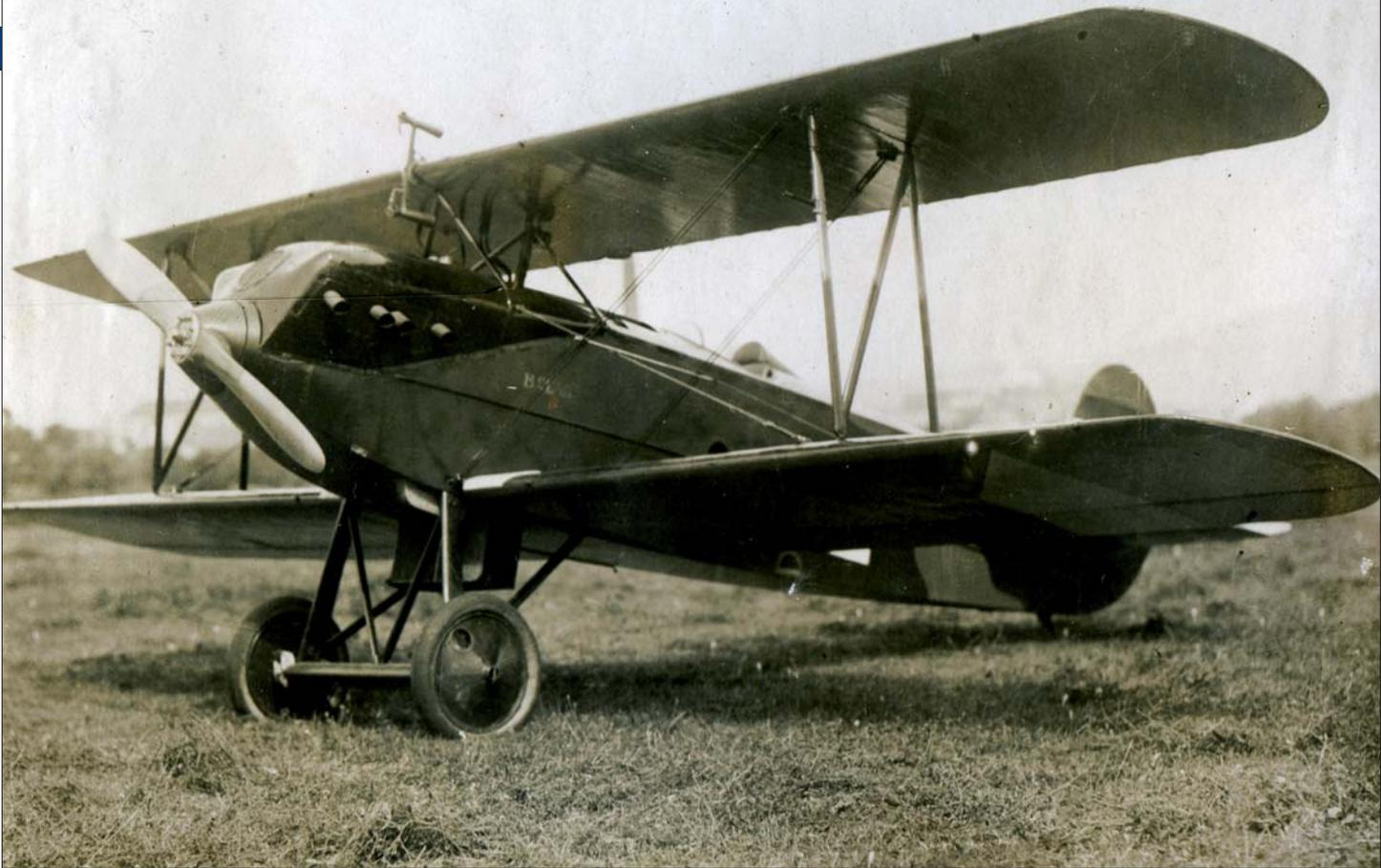
▲ Stihacie lietadlo Avia BH-21 dosahovalo rýchlosť 246 km/h. Bolo vyzbrojené - rovnako ako Aero A-18 - dvoma synchronizovanými guľometmi. The Avia BH-21 fighter reached 246km/h (153mph). Like the Aero A-18, it was equipped with two synchronized machine guns. Die Höchstgeschwindigkeit des Jagdflugzeuges „Avia BH-21“ betrug 246 km pro Stunde. Die Maschine war - genau wie die „Aero A-18“ - mit zwei synchronisierten Maschinengewehren bewaffnet.
