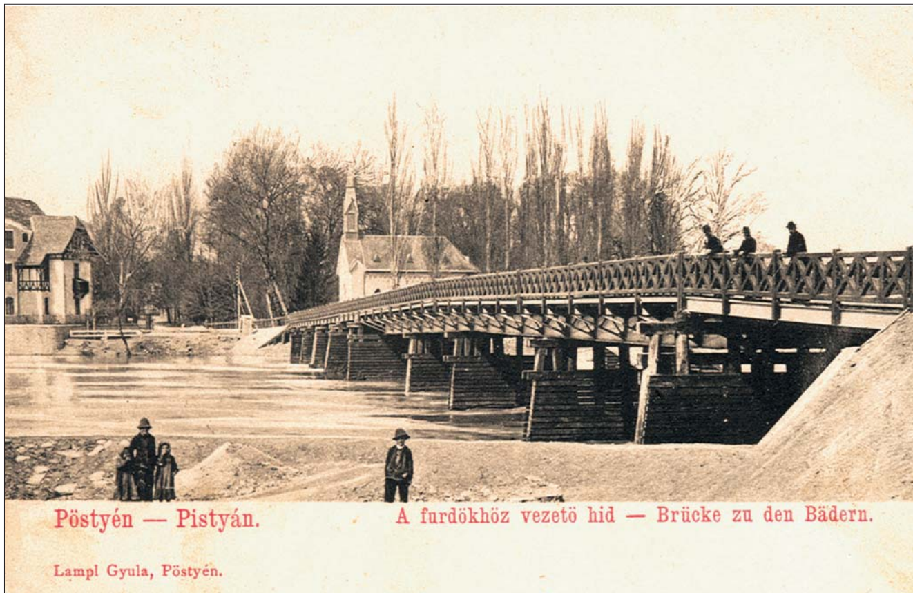
▲ Starý drevený most cez Váh, na druhej strane rieky Kúpeľná kaplnka a vila Löger. Pohľadnicu vydal Július Lampl tesne po roku 1900. An old wooden bridge across the Váh River and on the opposite side of the river the Spa Chapel and Villa Löger. This postcard was printed by Július Lampl just after 1900. Die alte Holzbrücke über die Waag; auf dem anderen Flussufer die Kurkapelle und die Villa „Löger“. Diese Ansichtskarte wurde von Július Lampl, unmittelbar nach dem Jahr 1900, herausgegeben.
