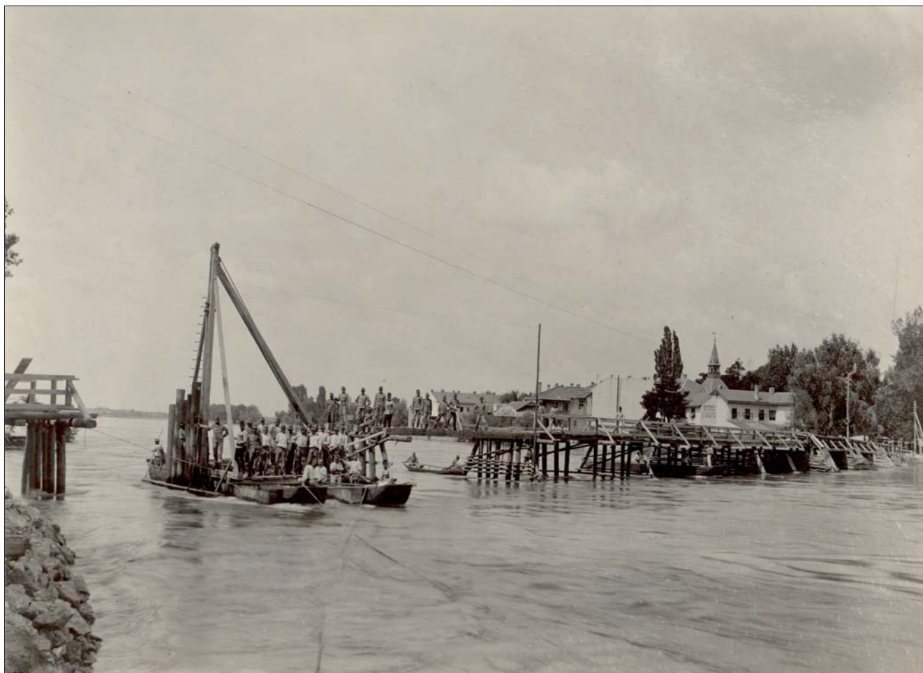
▲ Stavba dreveného mosta cez Váh v Piešťanoch (1903). Construction of the wooden bridge across the Váh in Piešťany (1903). Der Bau der Holzbrücke über die Waag in Piešťany (1903)
