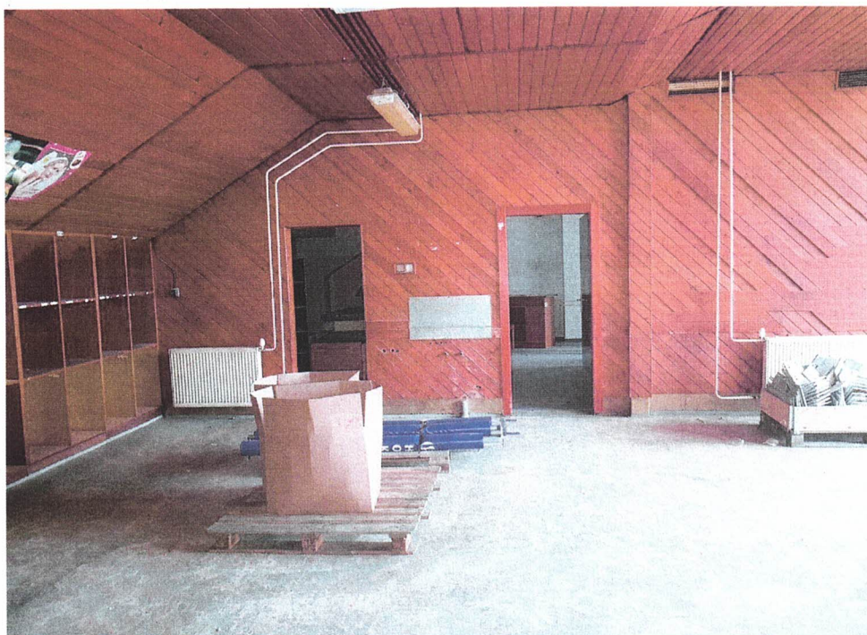
obchodno-skladové priestory č.2 prízemie
