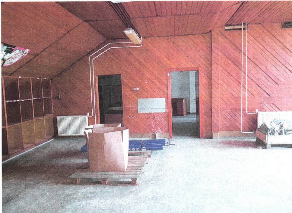
obchodno-skladové priestory č.2 prízemie
