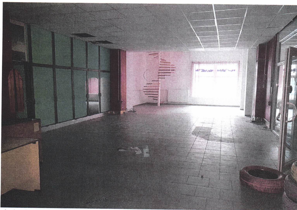
obchodno-skladové priestory č.1 prízemie
