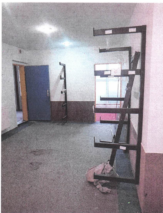
obchodno skladové priestory č.2 prízemie
