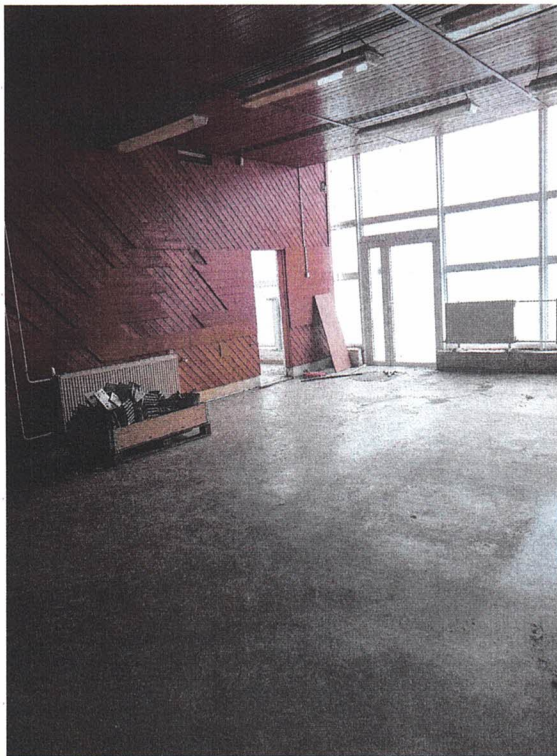
priestory č.2 prechod do WC
