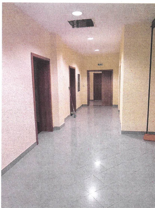
WC, kancelárie, vstupné priestory Jágr bar
