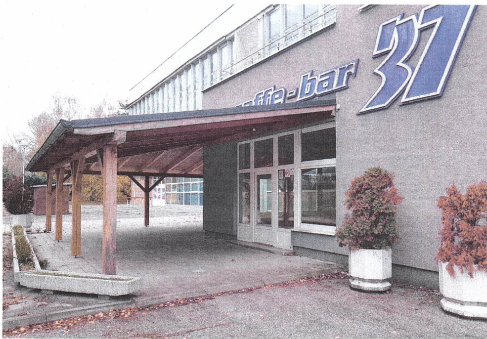
terasa vstup do caffe baru 37 na prizemi
