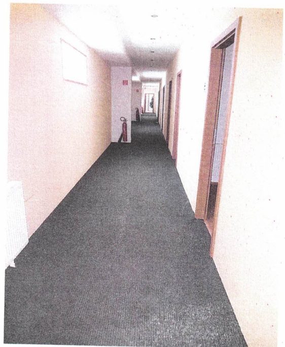
vstupná chodba do kancelárii III.NP
