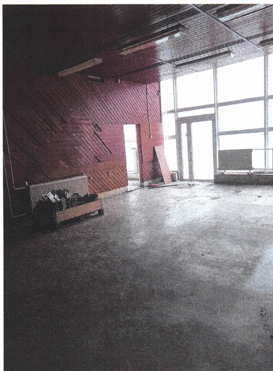
priestory č.2 prechod do WC
