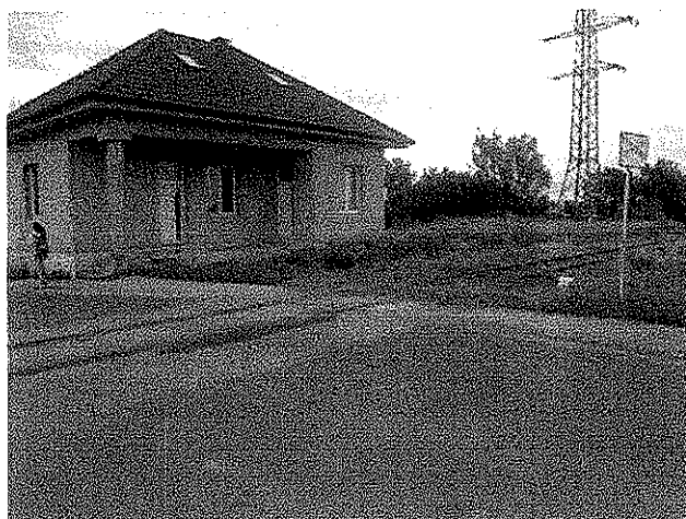
Obr. 2 Železničná stanica Krakovany
