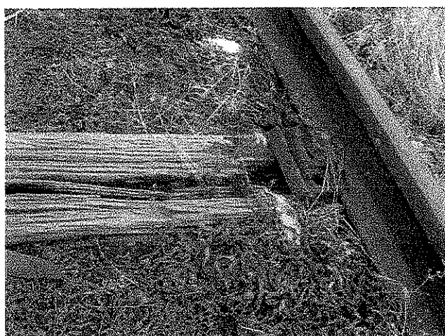
Obr. 3 Spráchnivené podvaly
