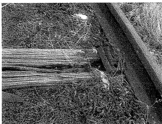
Obr. 3 Spráchnivené podvaly
